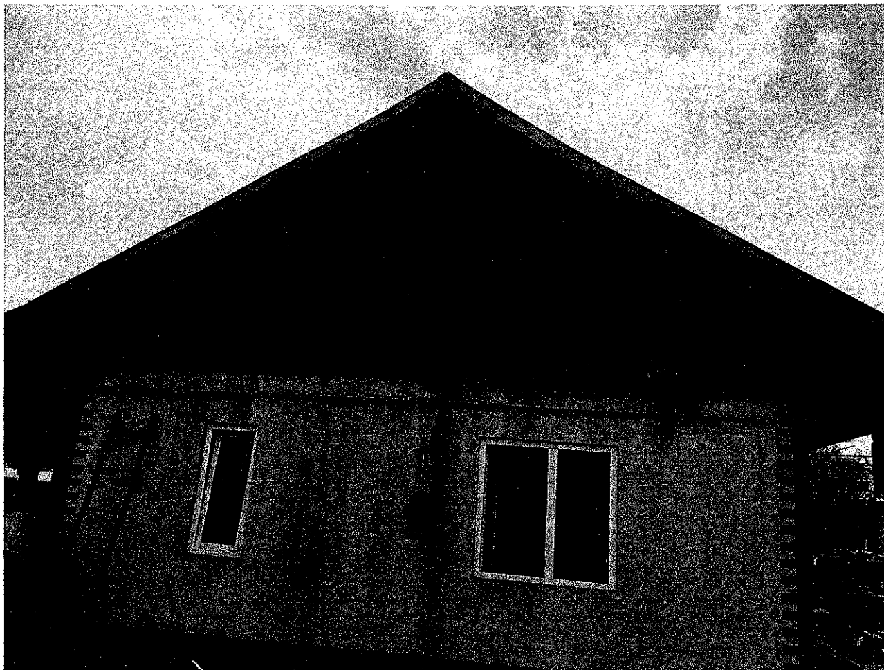
Casa de locuit de la numărul 8 are afectat în totalitate acoperișul pe o suprafață de 140 mp, planșeul și parțial pereții exteriori
