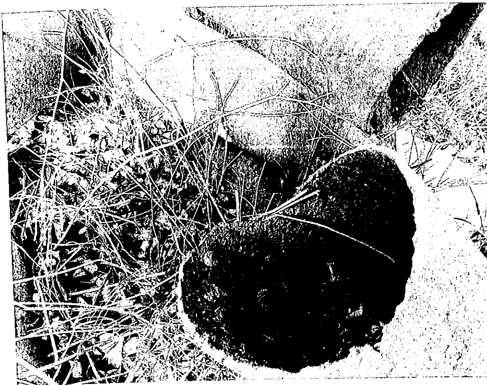
Conducte Dn 200 mm provenite din dezafectări rețele termice (punct Termic Cuza Vodă I și Cuza Vodă H).
