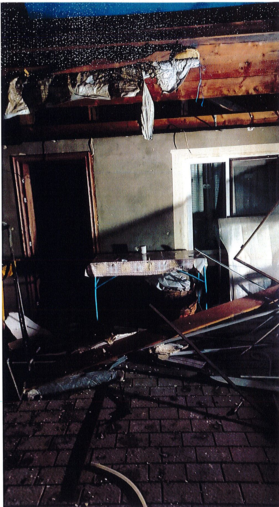
Afectare anexei gospodărești de la imobilul nr. 100
