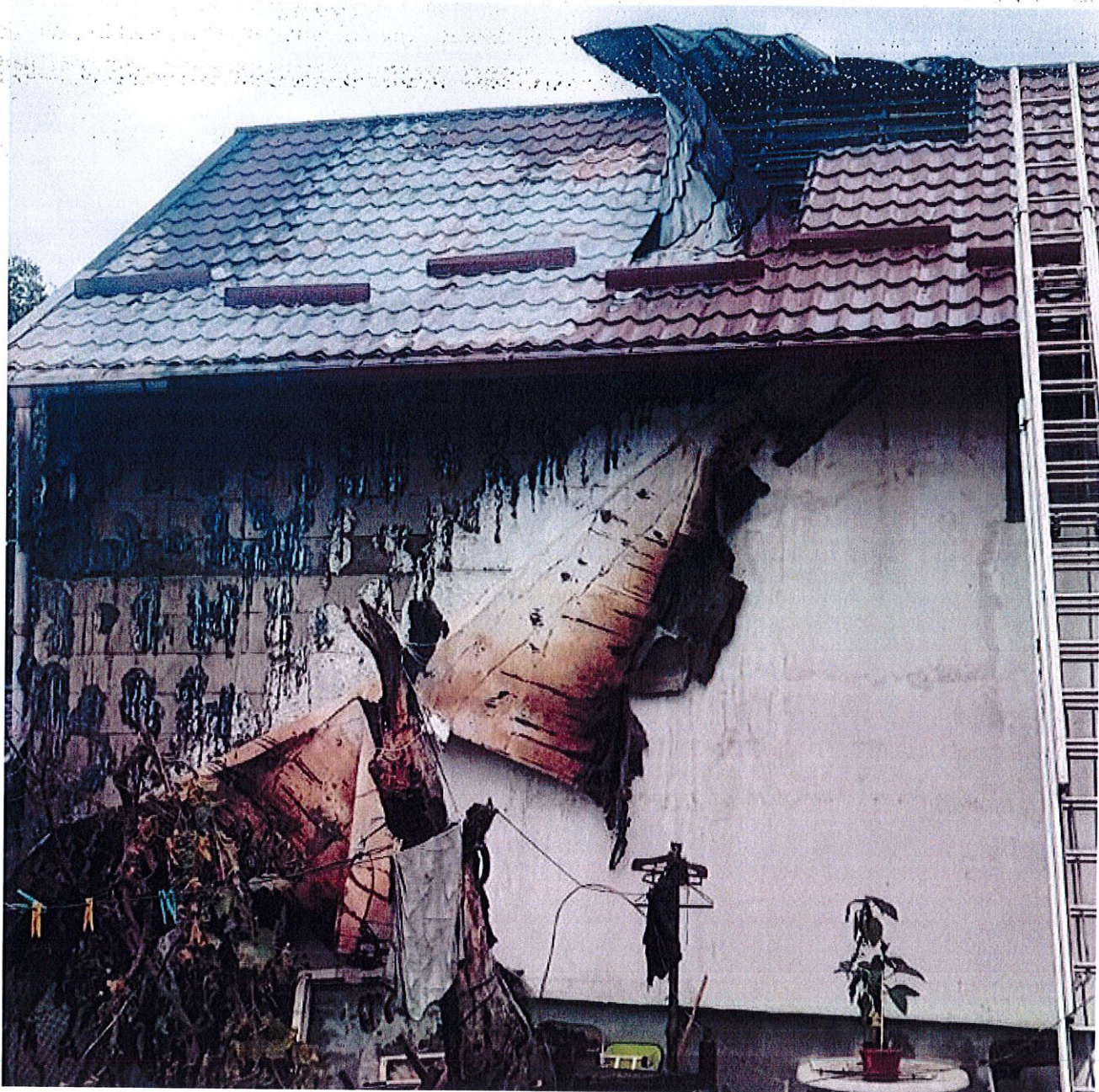
Distrugeri cauzate de incendiu la nivelul fațadei și acoperișului la imobilul de pe strada Cernăuți, nr. 100 (învecinat cu imobilul de la care s-a produs incendiul și ulterior s-a propagat la acesta)
