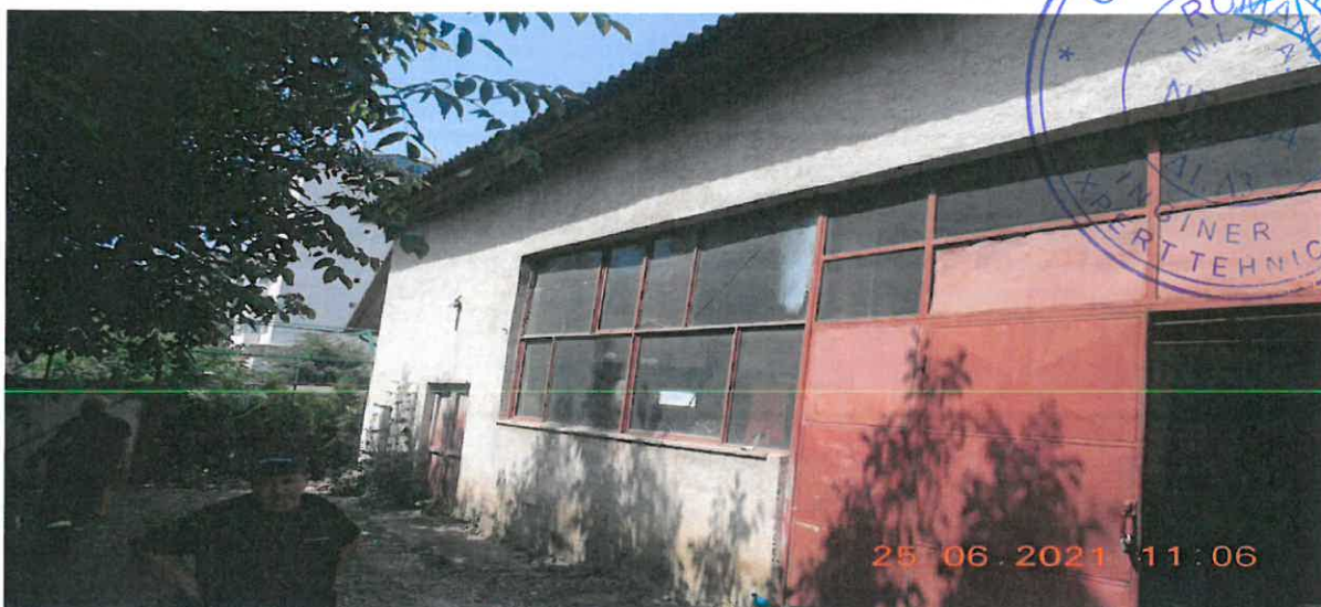
PT SCOALA SPECIALA - Foto exterior 2
