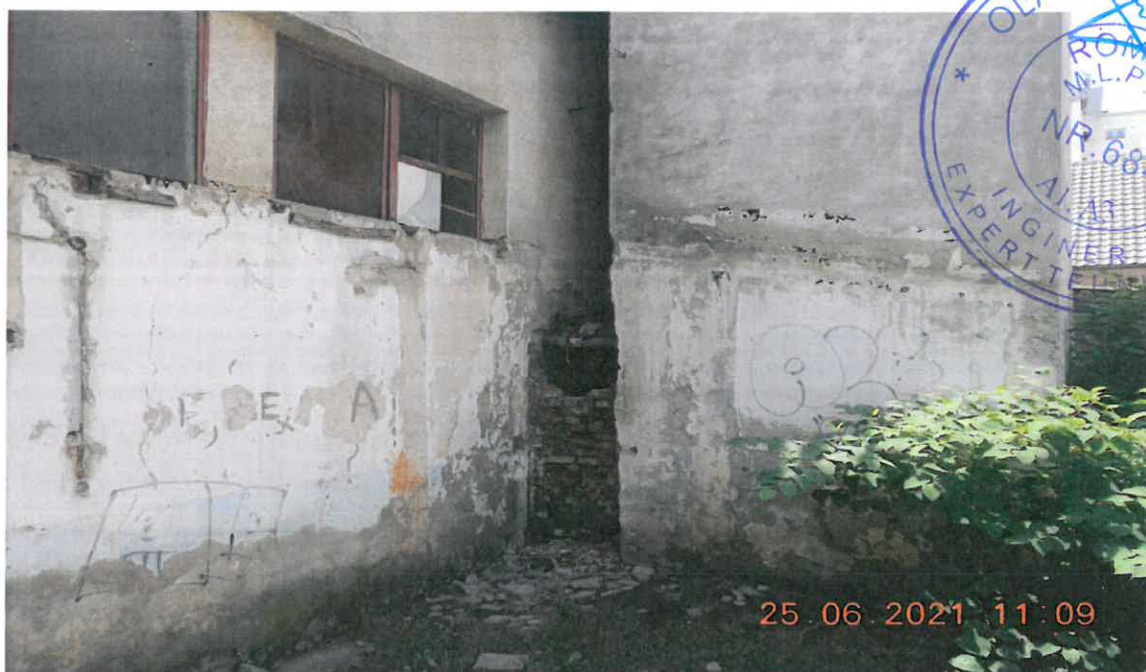
PT SCOALA SPECIALA - Foto exterior 4
