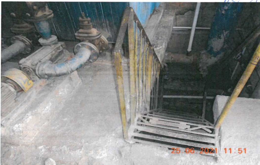
PT CUZA VODA H - Foto interior 3
