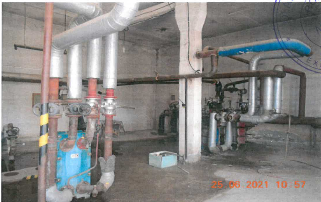
PT CUZA VODA 5 - Foto interior 3
