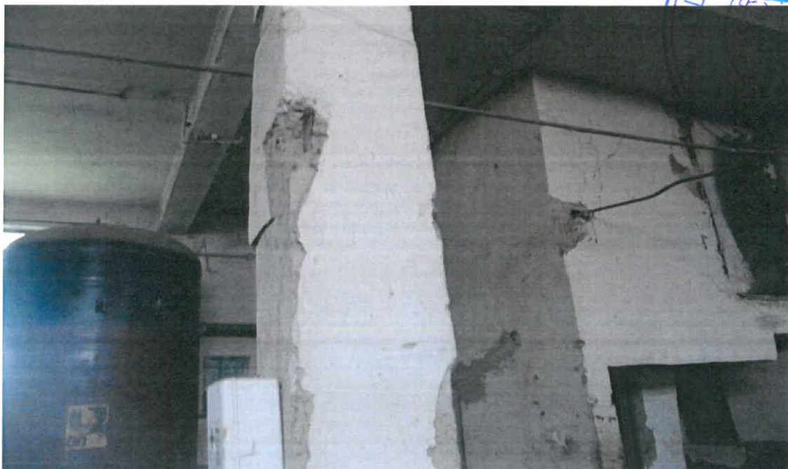
PT GARA - Foto interior 5
