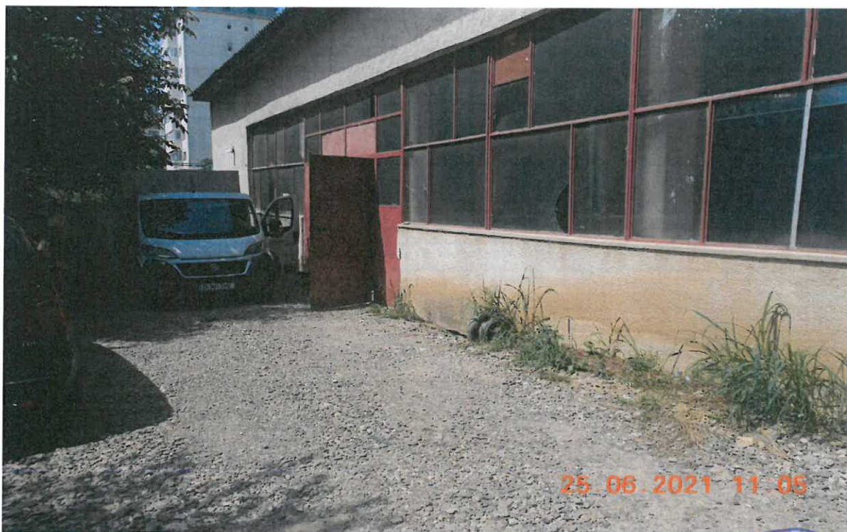
PT SCOALA SPECIALA - Foto exterior 1
