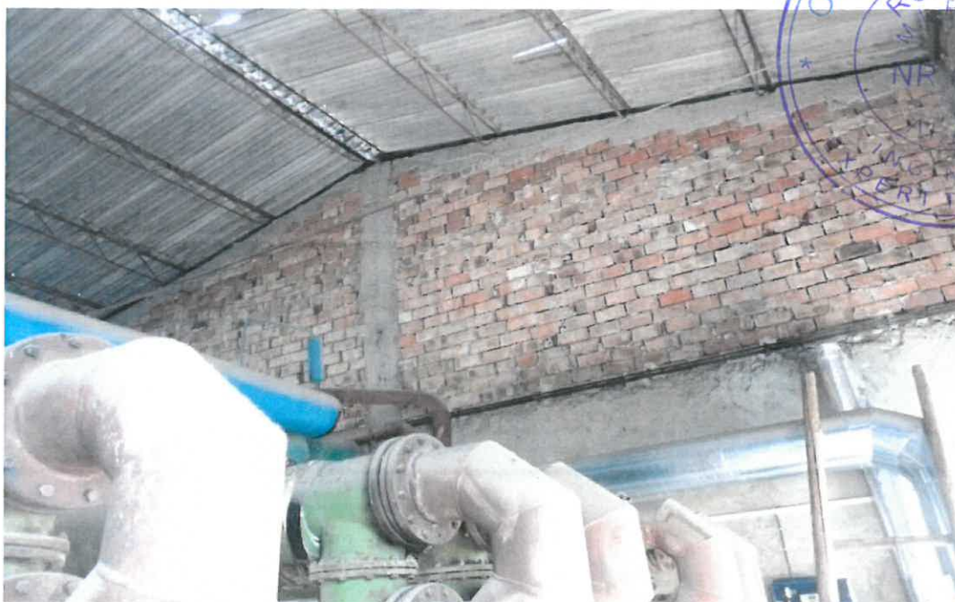
PT CUZA VODA H - Foto interior 7
