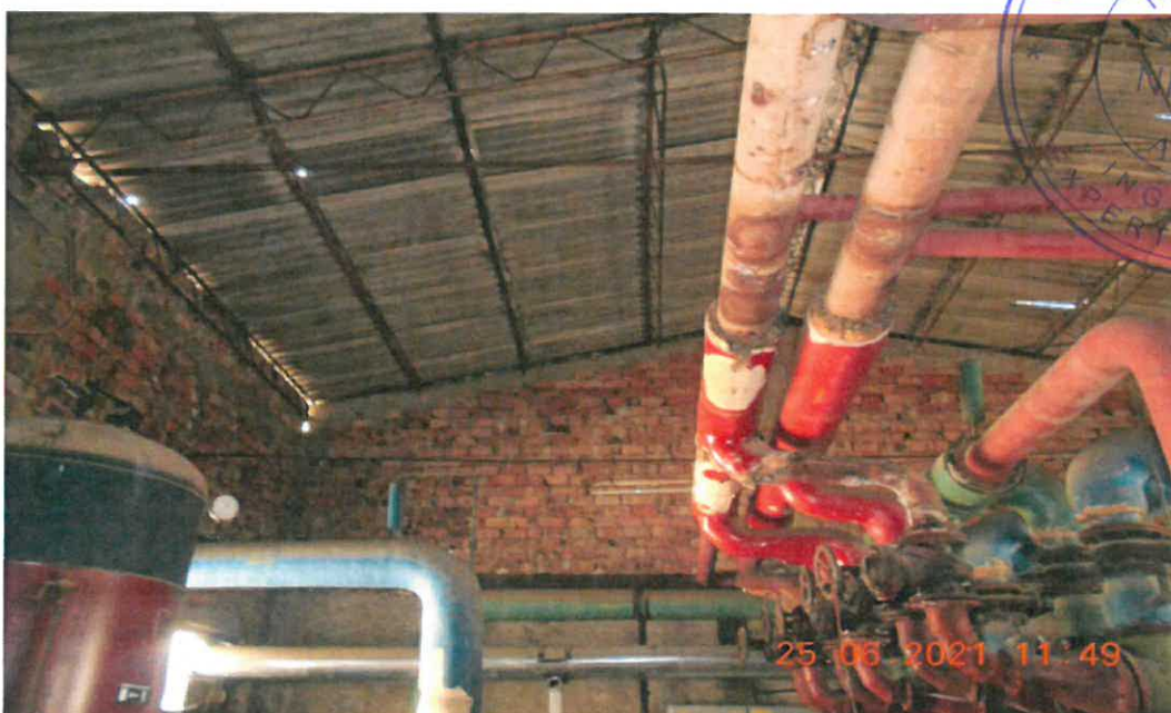
PT CUZA VODA H - Foto interior 1
