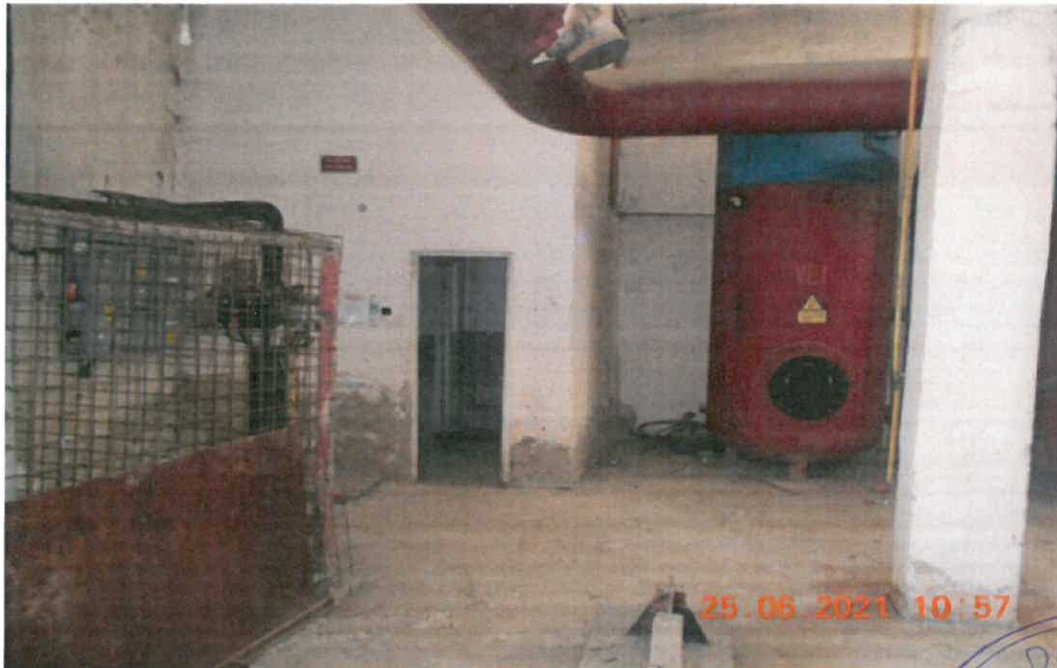
PT CUZA VODA 5 - Foto interior 2
