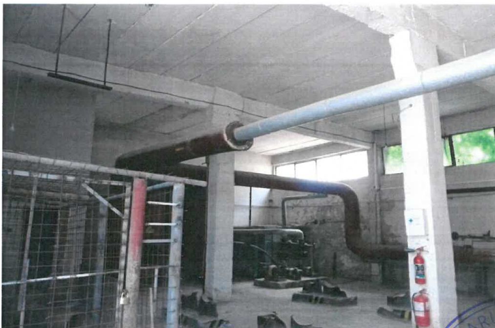
PT CUZA VODA 4 - Foto interior 2
