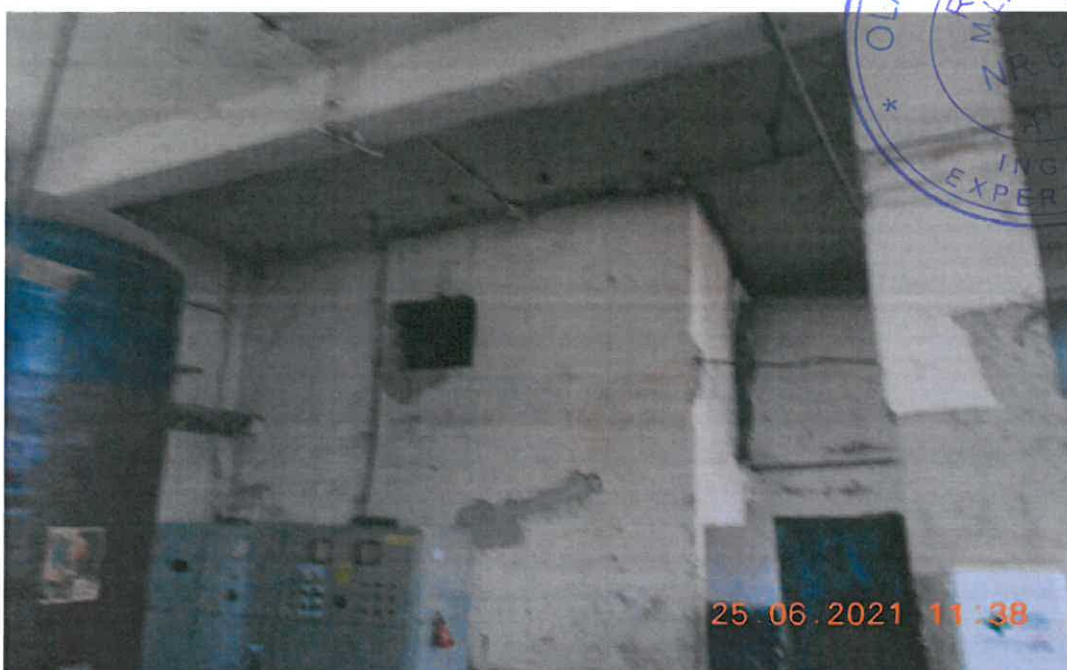
PT GARA - Foto interior 3
