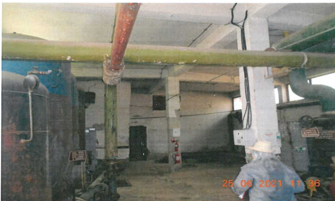
PT GARA - Foto interior 4
