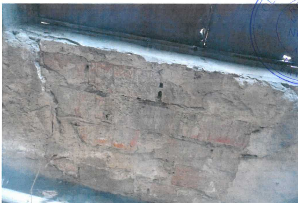
PT CUZA VODA H - Foto interior 5
