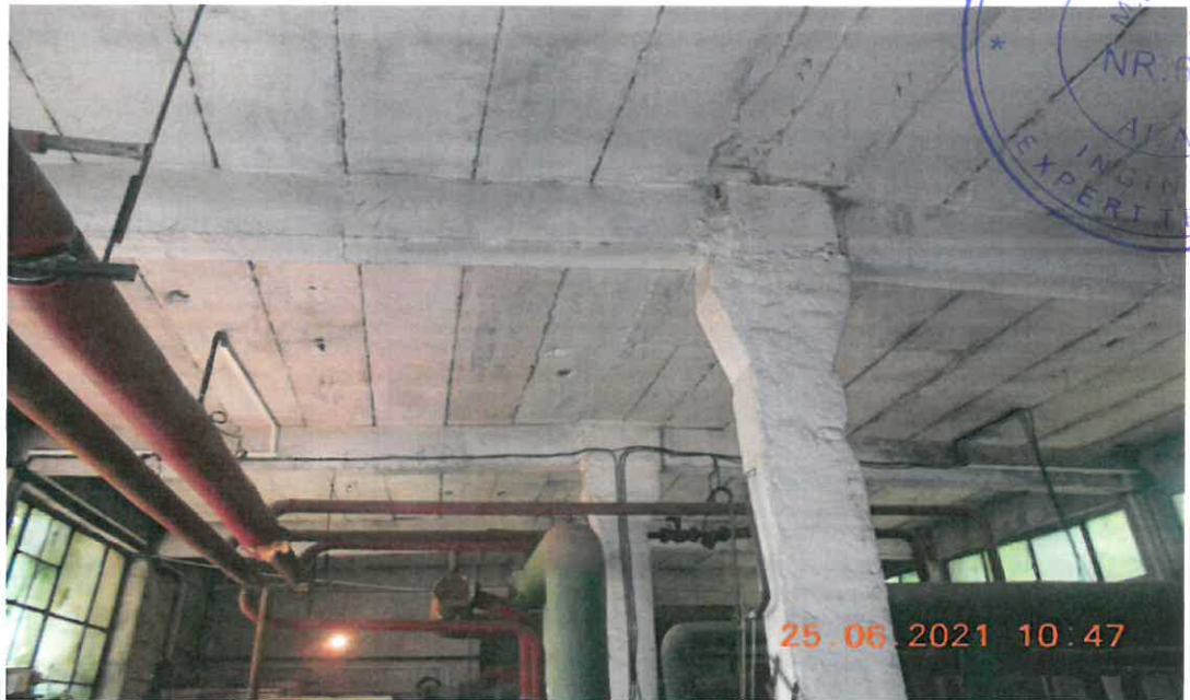
PT CUZA VODA 4 - Foto interior 1
