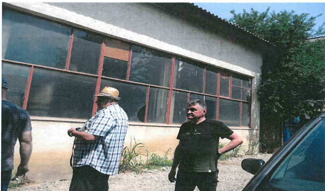
PT SCOALA SPECIALA - Foto exterior 3
