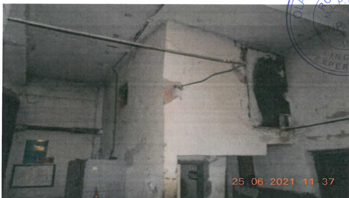
PT GARA - Foto interior 1
