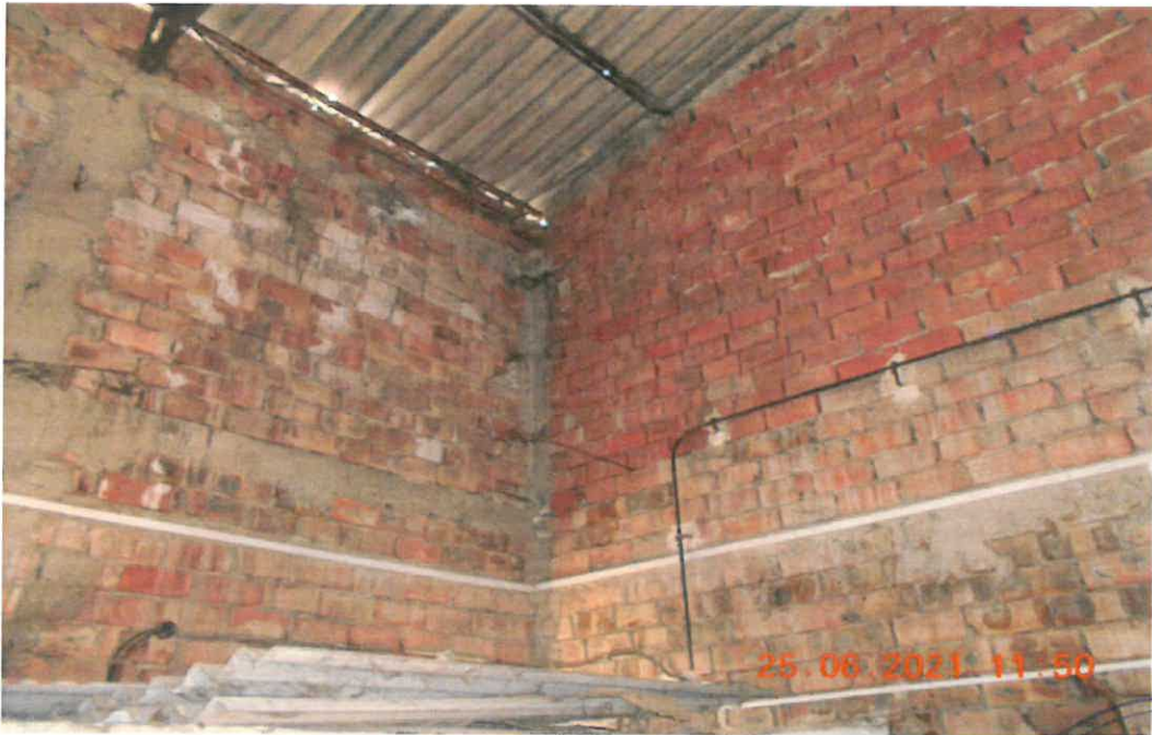
PT CUZA VODA H - Foto interior 2
