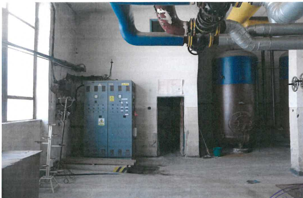
PT CUZA VODA 2 - Foto interior 2
