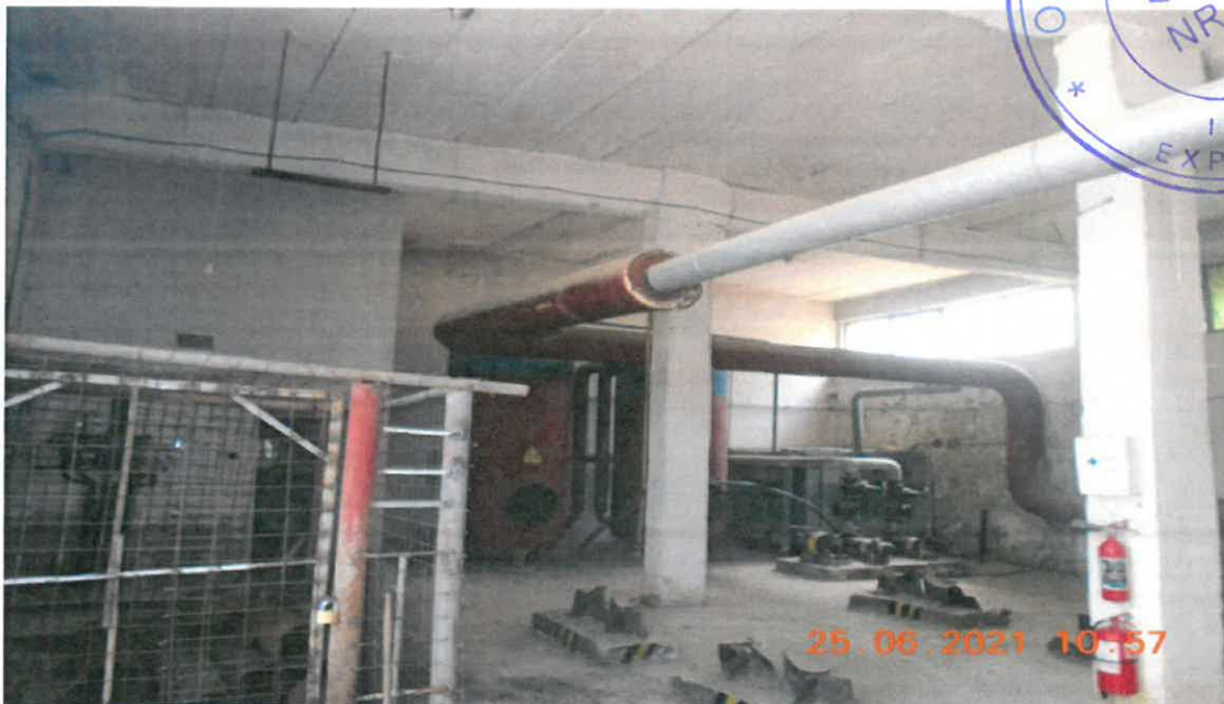
PT CUZA VODA 5 - Foto interior 1
