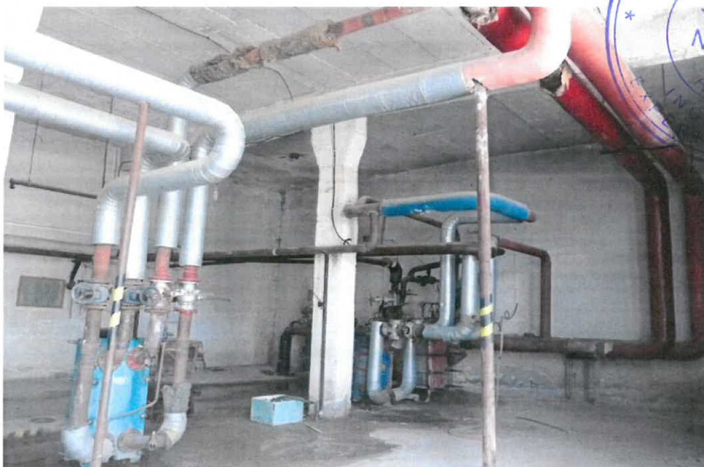
PT CUZA VODA 4 - Foto interior 3
