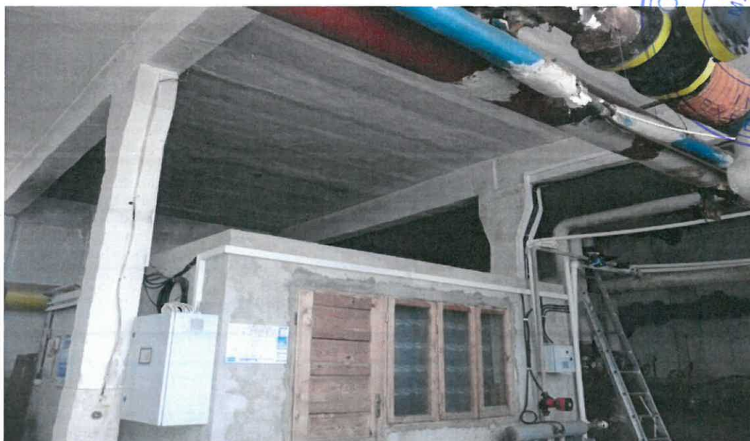
PT CUZA VODA 2 - Foto interior 1
