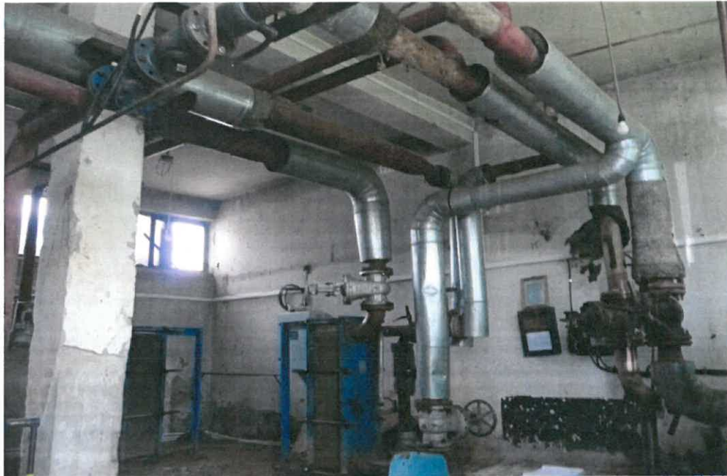
PT CUZA VODA 1 - Foto interior 2
