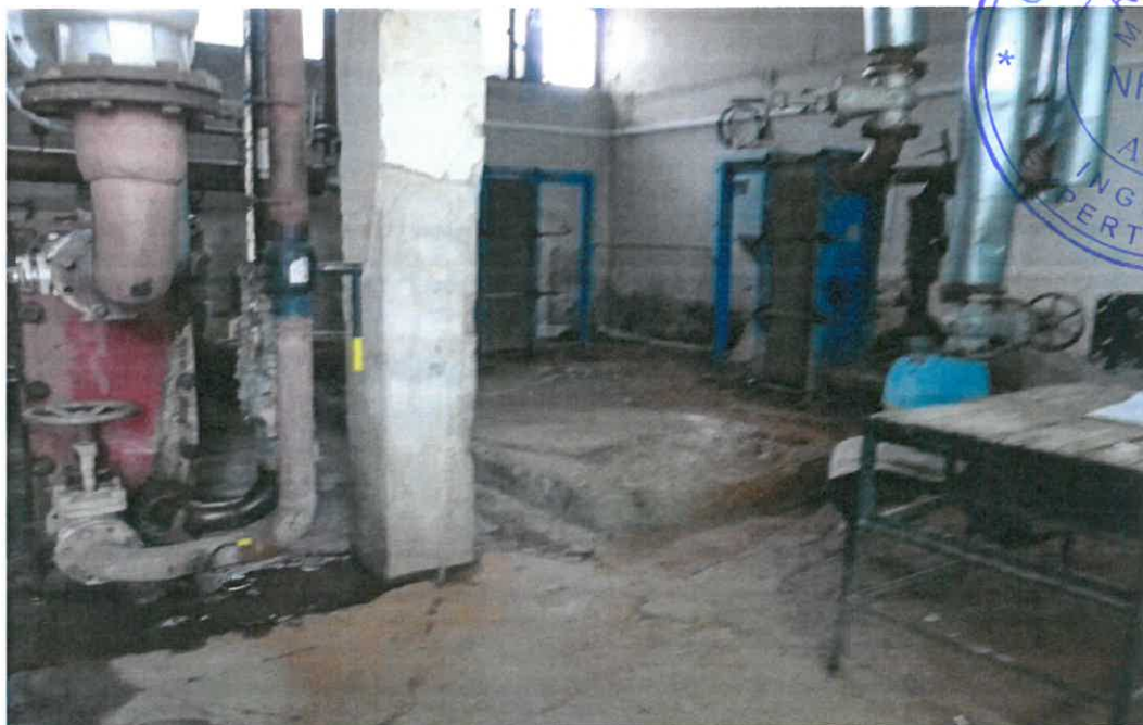
PT CUZA VODA 1 - Foto interior 3
