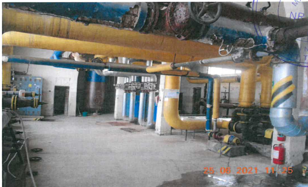
PT CUZA VODA 1 - Foto interior 1
