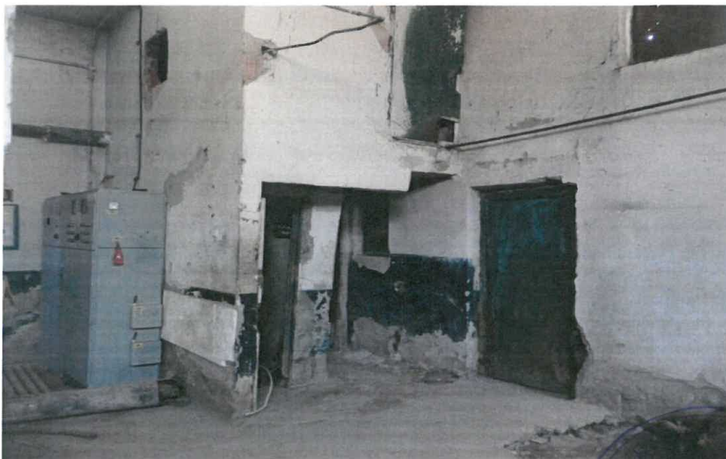
PT GARA - Foto interior 2
