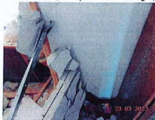
Figura 40 Perete din zidărie de BCA dislocat
