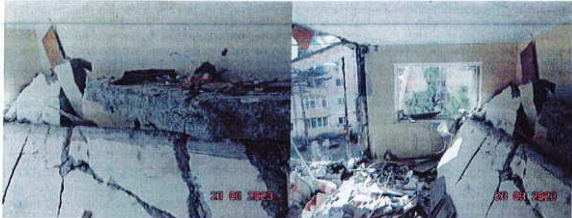
Figura 37 Armare panouri interioare
