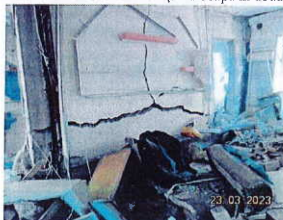
Figura 36 Cedare perete interior ax 13/A-B
