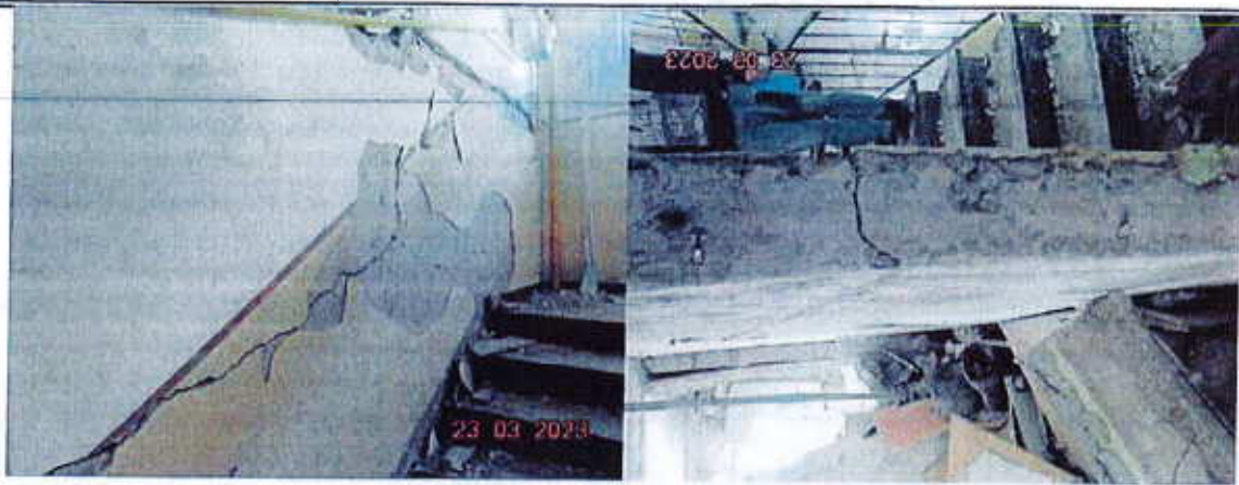
Figura 39 Degradare a peretelui din axul 13/B-C
