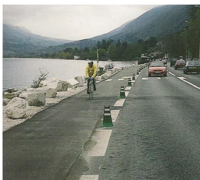
Figura 44 - Benzi ciclabile cu marcaje transparente și ușor de trecut (Sursa: Recommendations pour les aménagements cyclables, CERTU, 2008)
