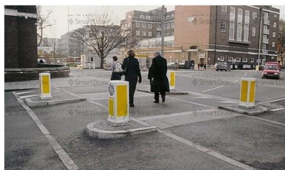
Figura 50 - amplasarea de mediane / refugii (despărțind cele două sensuri) pentru a reduce distanța de traversare și timpul traversării
