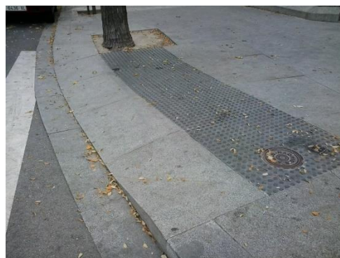
Figura 47 – exemple de rampe la bordură semnalizate cu suprafețe tactile (sursa: O Stepan)
