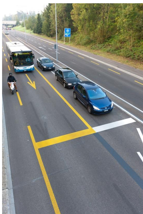
Figura 36 - bandă dedicată TP în zona peri-urbană a Zurich-ului – există și culoar separat pentru utilizatorii vehiculelor cu două roți (sursa: www.eltis.org )
