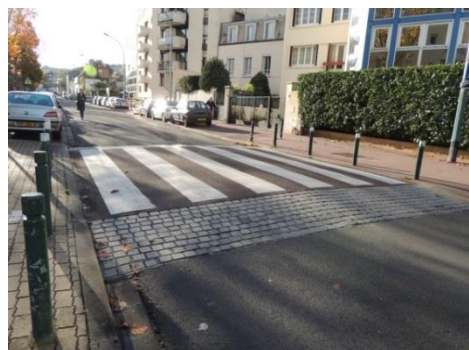
Figura 48 – treceri de pietoni înălțate la cota trotuarului (sursa: O Stepan)
