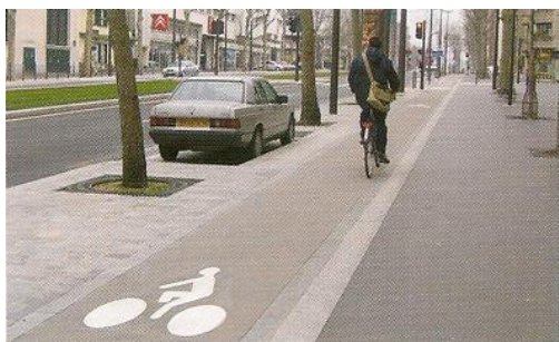
Figura 46 - Pistă ciclabilă pe trotuar (Sursa: Recommendations pour les aménagements cyclables, CERTU, 2008)
