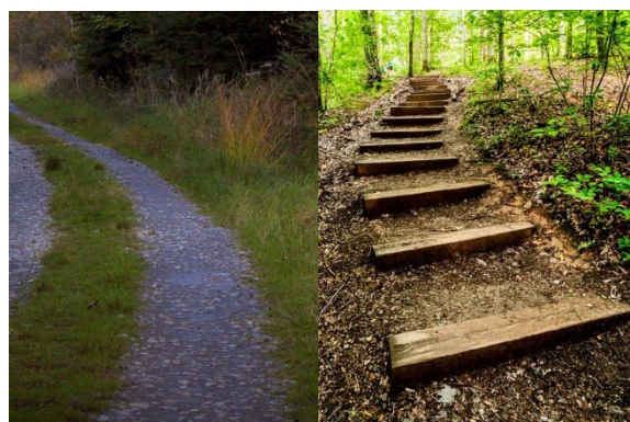
Exemplu finisaj - pământ stabilizat + trepte din lemn
