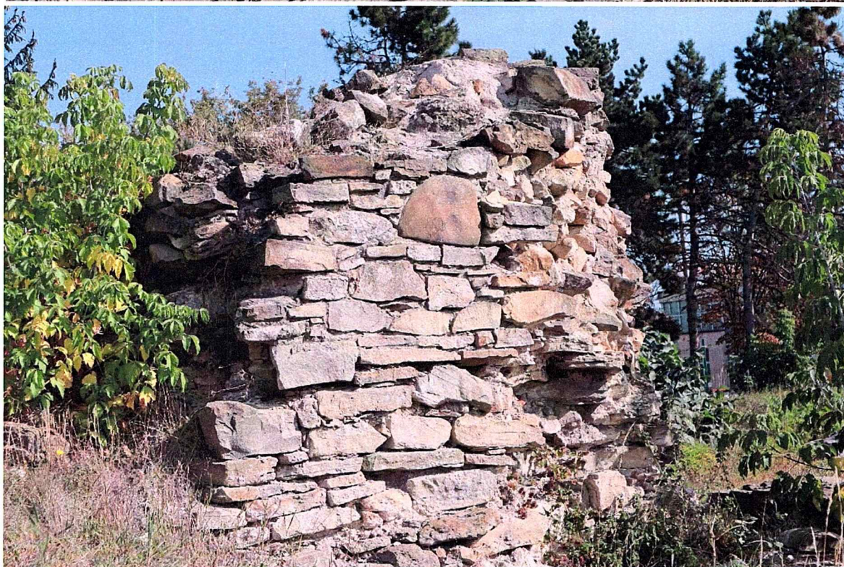
Tronsoane de zidărie din etape diferite de construcție a curții domnești
