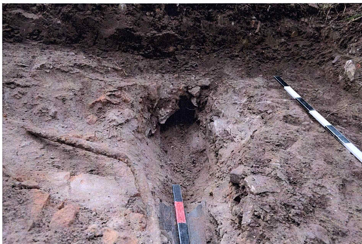
Planșa 9 Caseta C 7 la nord de ruinele curții- se observă țevile de apă și canalizare după înlăturarea stratului de nisip și pietriș. Țeava de apă este încă în funcțiune și alimentează blocuri din apropiere.
