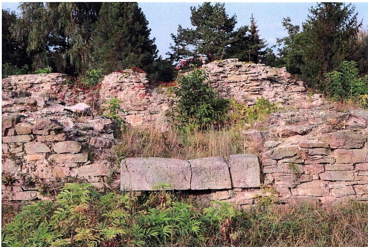
Pragul unei încăperi a curții domnești care se găsește deja la aproape 0,60 m deasupra solului, dovedind răzuirea puternică a terenului în etapele ulterioare
