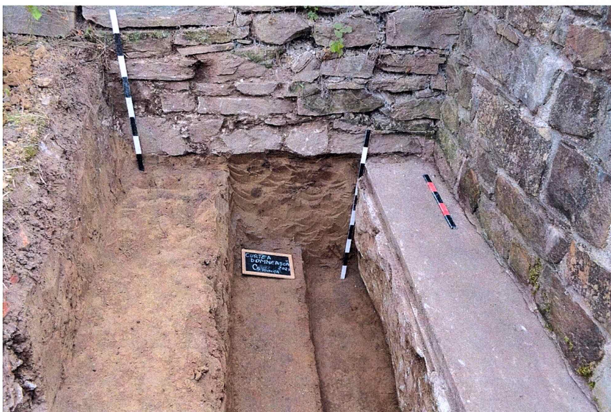
Planșa 7 Caseta C 5 pivniță se poate observa că întregul zid este operă de restaurare cu protecție suplimentară prin pinden de beton
