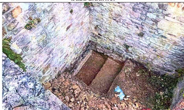
Imagine de ansamblu asupra stării generale de conservare - în imagine se pot observa săpăturile arheologice lăsate neacoperite și care au permis pătrunderea apelor pluviale și menținerea umidității la baza zidurilor
