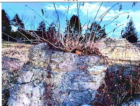
Locul de prelevare a probei nr. 10 - Ruinele turnul T 2 - Epoca Ștefan cel Mare (post 1485), partea de sud
