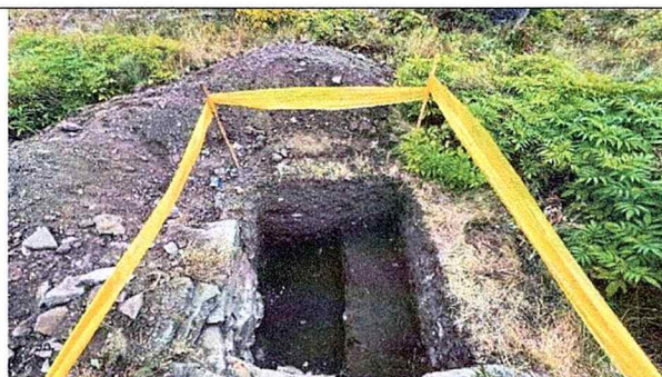
Imagine de ansamblu asupra stării generale de conservare - în imagine se pot observa săpăturile arheologice lăsate neacoperite și care au permis pătrunderea apelor pluviale și menținerea umidității la baza zidurilor
