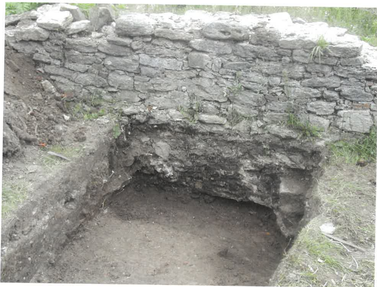
Fig. 17. Dezvelirea fundațiilor pentru construcția C 5, campania 2003.
